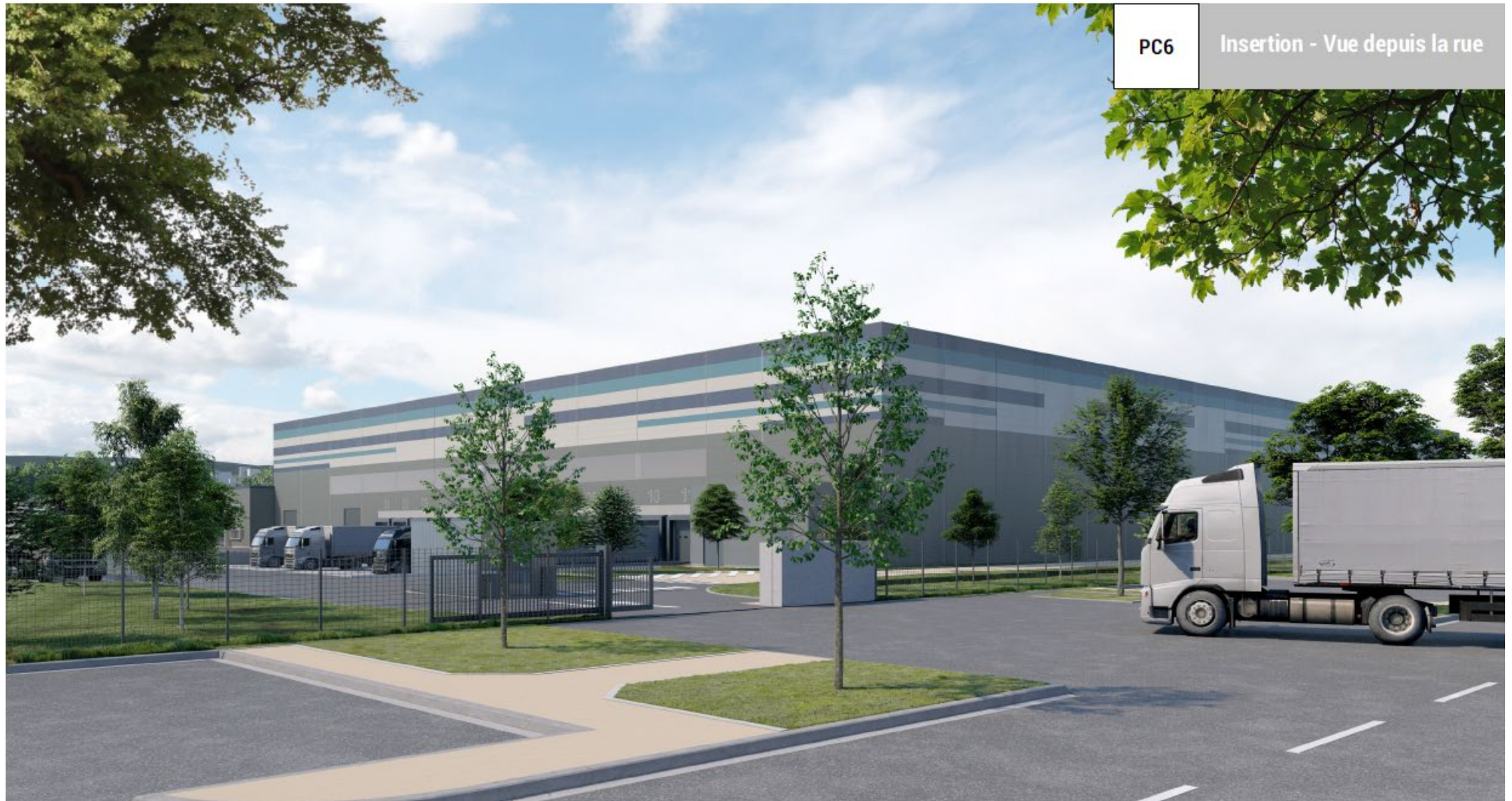
Figure 8: Vue du bâtiment depuis l'avenue Jules verne (extrait du permis de construire, image XXL Atelier)
